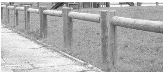
Steccato aperto con singola fila di pali
