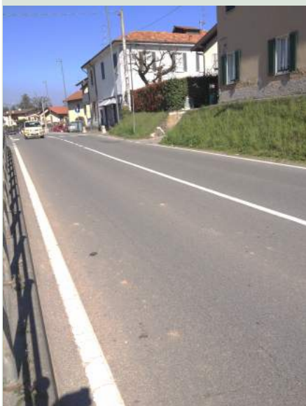
VIA DIAZ (altezza via Cantore)
