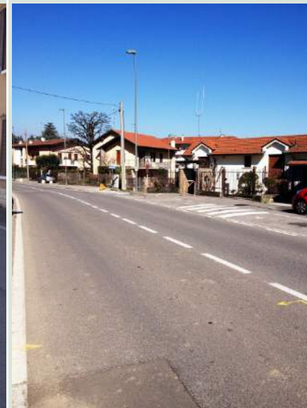
VIA DIAZ (altezza via Sauro)
