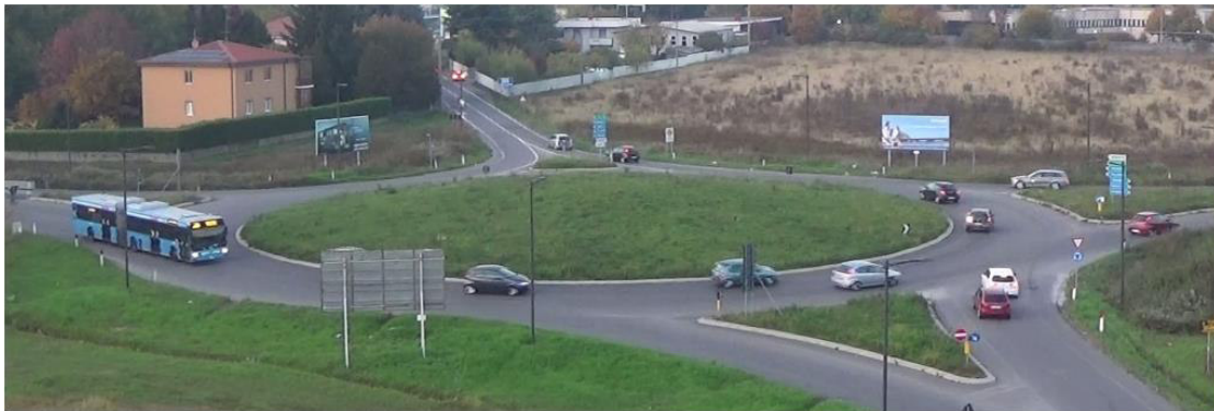
Foto 05 – Intersezione 1 – vista da sud
