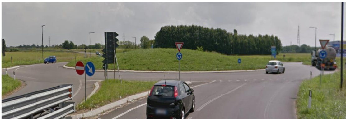
Foto 06 – Intersezione 1 – vista da ovest
