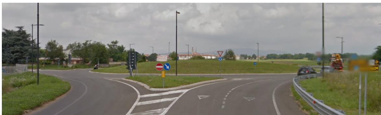
Foto 08 – Intersezione 3 – vista da sud
