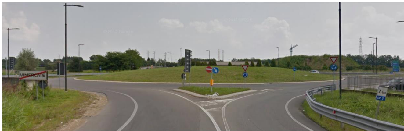
Foto 09 – Intersezione 3 – vista da ovest
