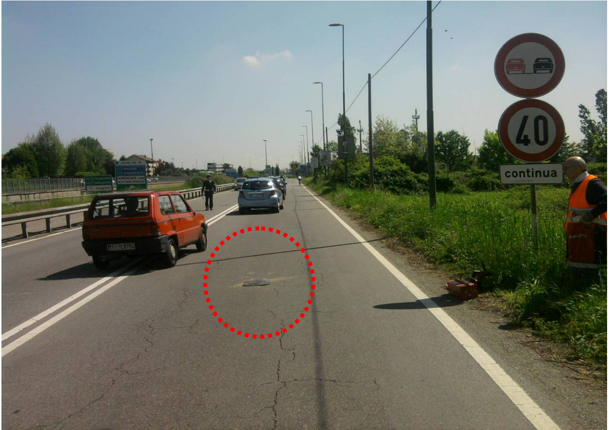
via Trieste, piastra posizionata in direzione Sud
