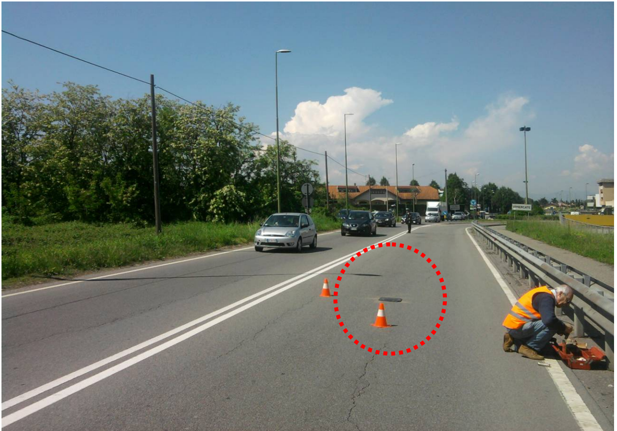
via Trieste, piastra posizionata in direzione Nord
