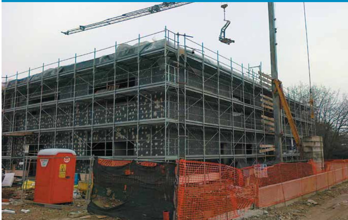
Il cantiere per la realizzazione del nuovo edificio in via Rossino.
